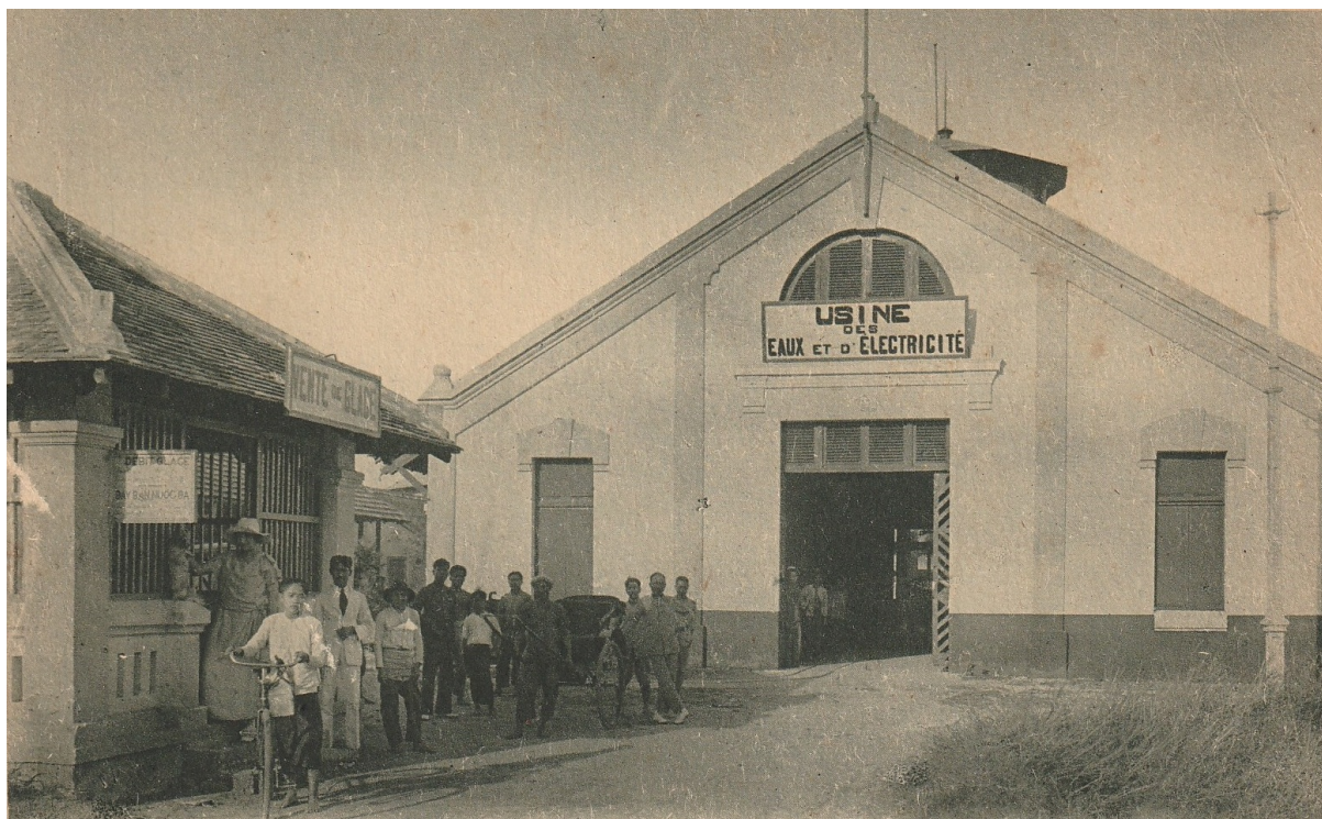
Coll. Olivier Galand Cantho. — Usine des eaux et d'électricité. Entrée de l'usine. (Photo Nadal, Saïgon. Gravure Braun & Cie, Dornach)(vers 1925).
