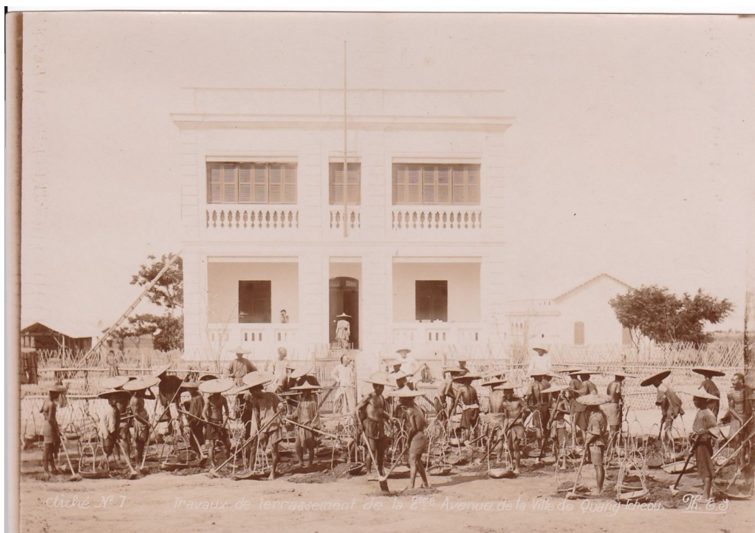
N° 7 Travaux de terrassement de la deuxième avenue de la ville de Quang-Tchéou
