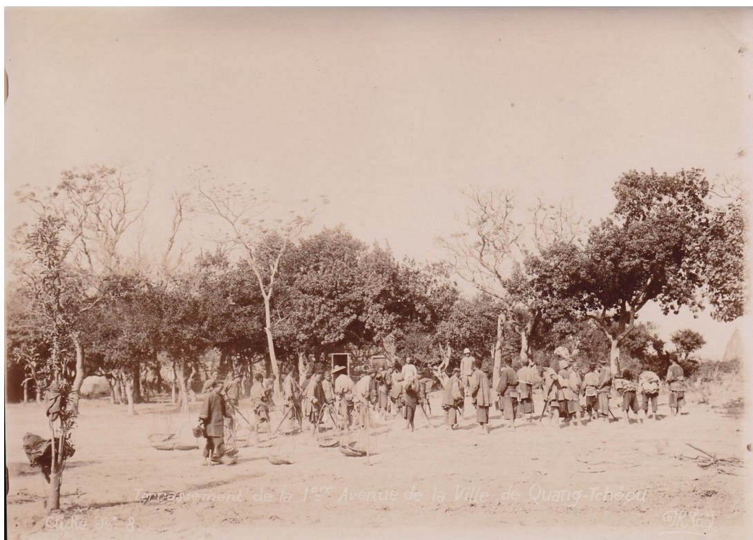
N° 8 Terrassement de la première avenue de la ville de Quang-Tchéou
