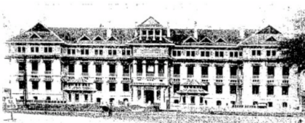
Le nouveau bâtiment de la Direction des Finances et de l'Enregistrement à Hanoï. Façade principale sur l'avenue Puginier et dans l'axe de l'avenue Van-Vollenhoven. Le mur de clôture n'est pas encore terminé.
