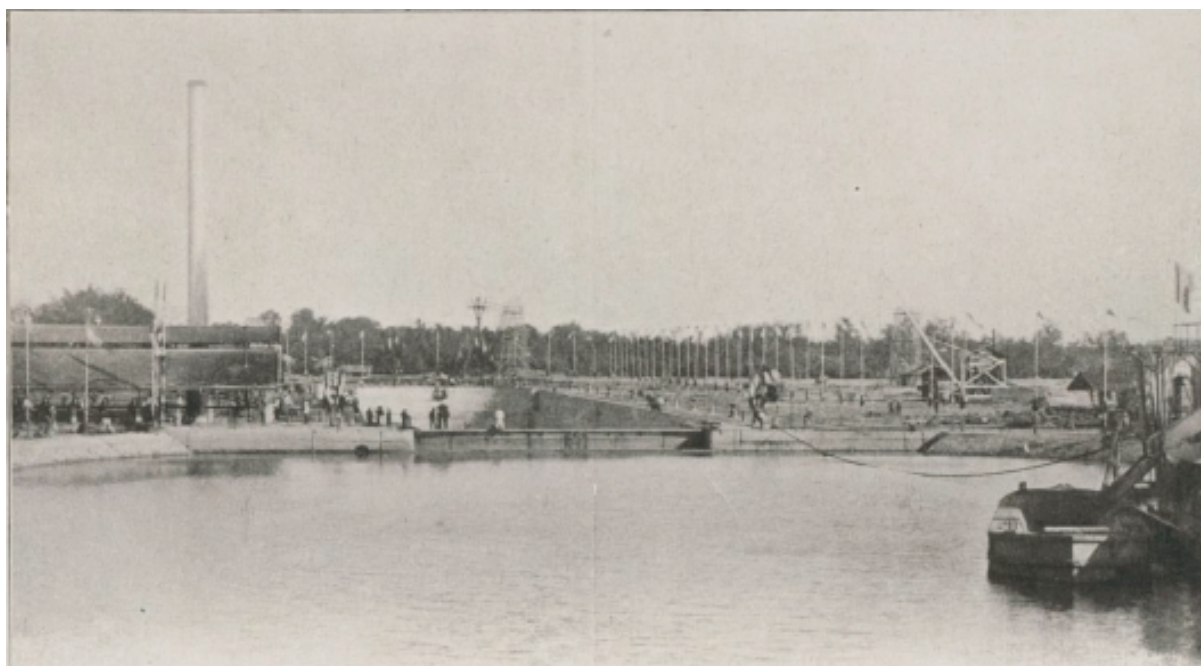
Bassin de radoub de Saïgon
