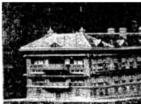
Façade latérale d'une des deux ailes.
