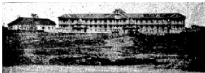
3) Devant l'Institut. Pasteur; on remblaie les dernières mares.
