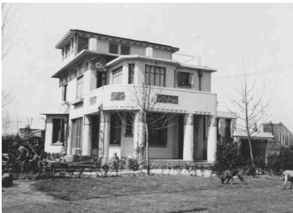
1927. — Maison d'Élise et Paul Veyseyre , route de Siéyès a Shanghai (actuelle Yong Jia Lu )
