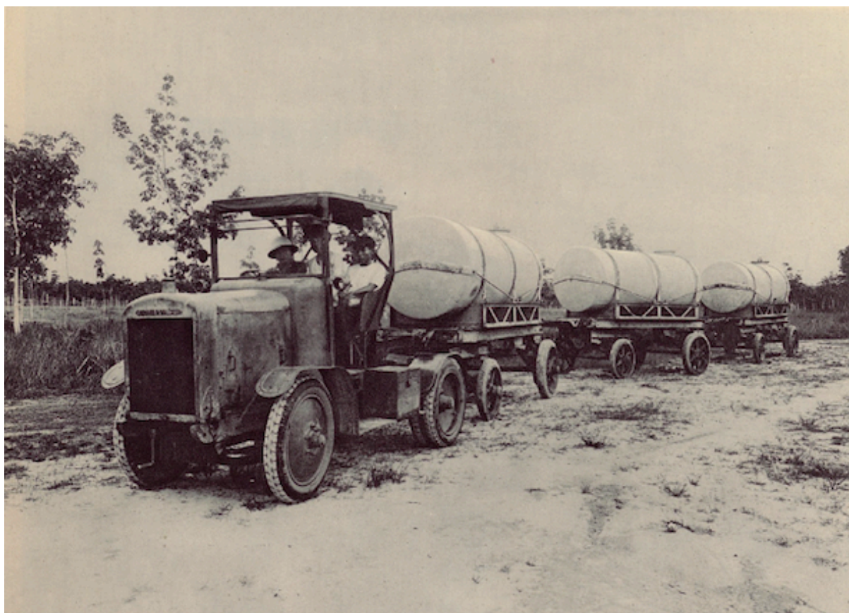
Planche 26. — Tracteur Chenard & Walcker avec remorques-citernes pour le transport des vidanges de la ville de Saïgon sur la plantation
