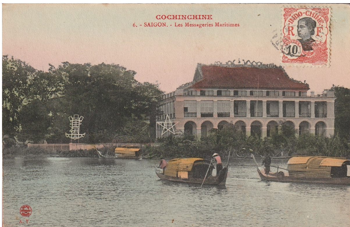
Le siège des Messageries maritimes à Saïgon (1913)
