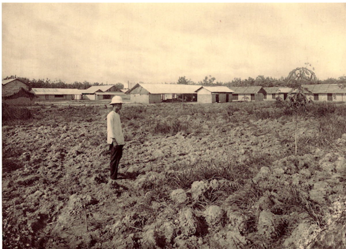
Planche 122. — Vue d'ensemble des bâtiments de la plantation.
