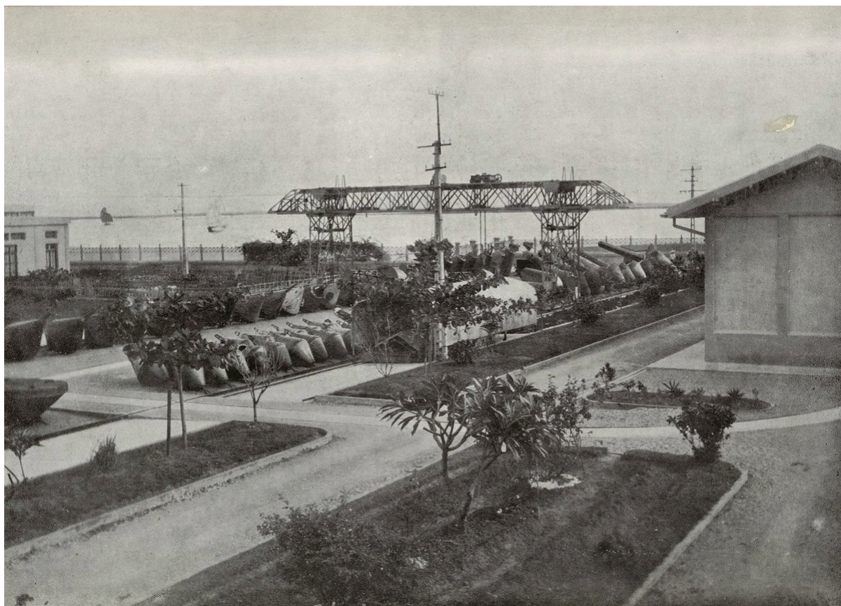
Appontement du parc de balisage de Haïphong ( Annales des travaux publics de l'Indochine française , 1943, p. 68)
