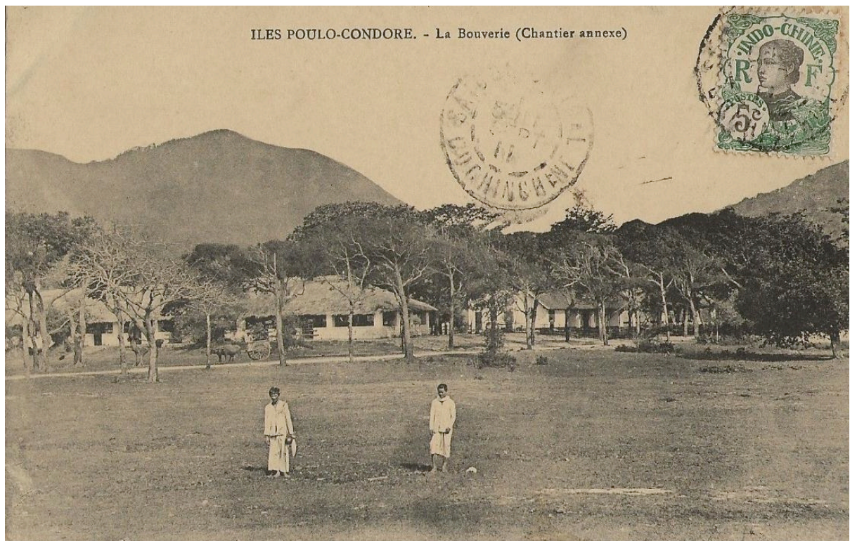
La bouverie (chantier annexe).
