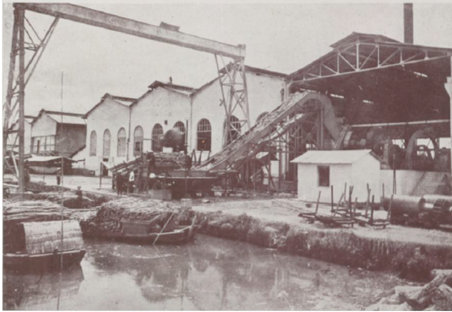
Usine de Hiep-Hoa. Élévateur de cannes
