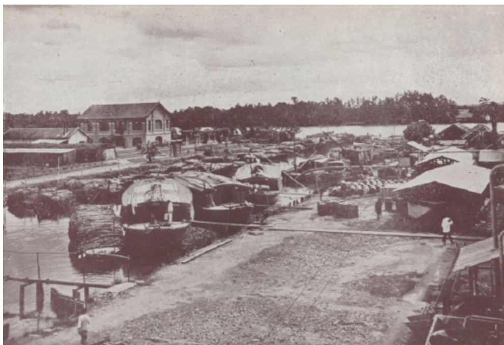
Usine de Hiep-Hoa. Vue du bassin
