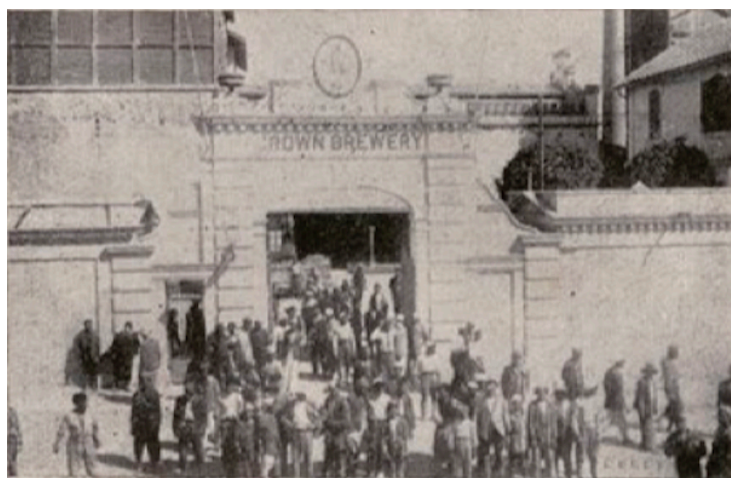
Sortie des ouvriers de l'usine à Ibrahimieh
