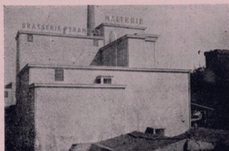
Nouveaux bâtiments de la Malterie de Ghizeh.
