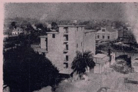
Vue d'ensemble des nouveaux bâtiments de la Malterie de Ghizeh.
