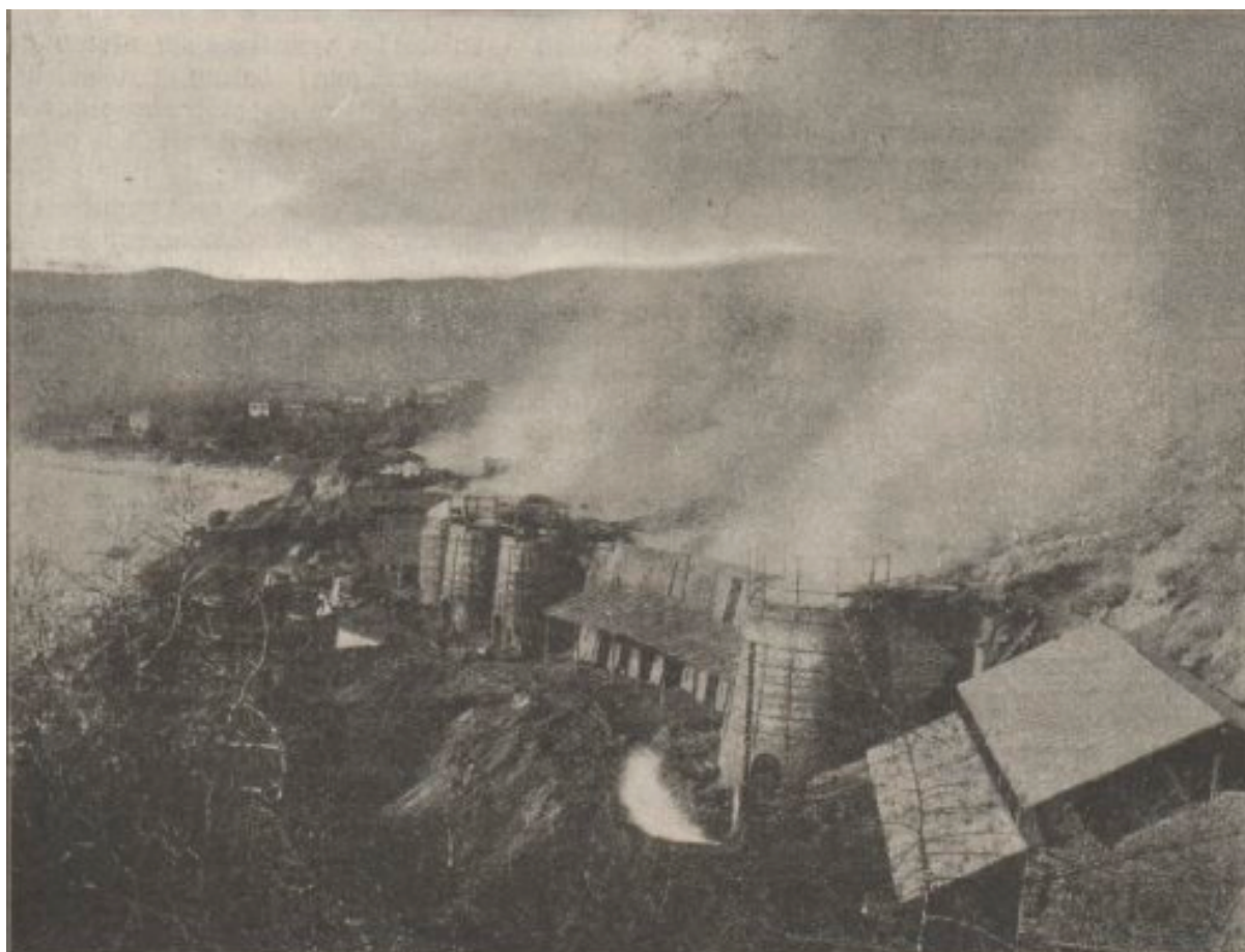
Fours de grillage de la Société des mines de Kassandra à Stratoni (Turquie) ( Le Génie civil , 24 mars 1906)
